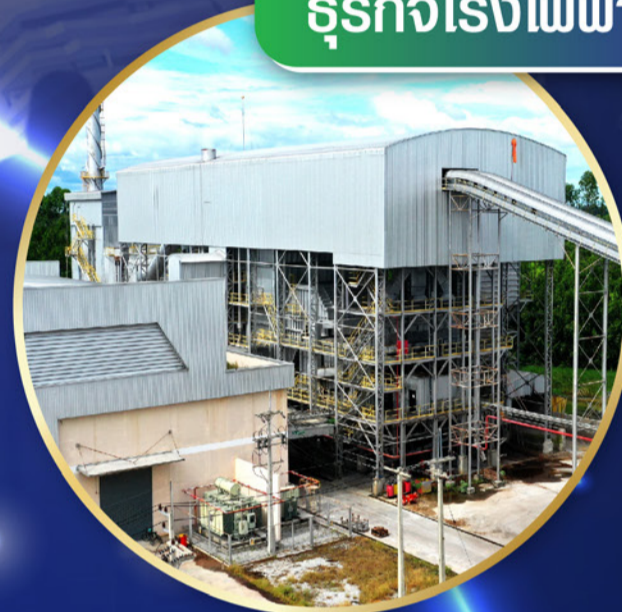
ธุรกิจโรงไฟฟ้า
