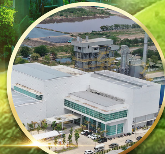
ธุรกิจโรงไฟฟ้า
