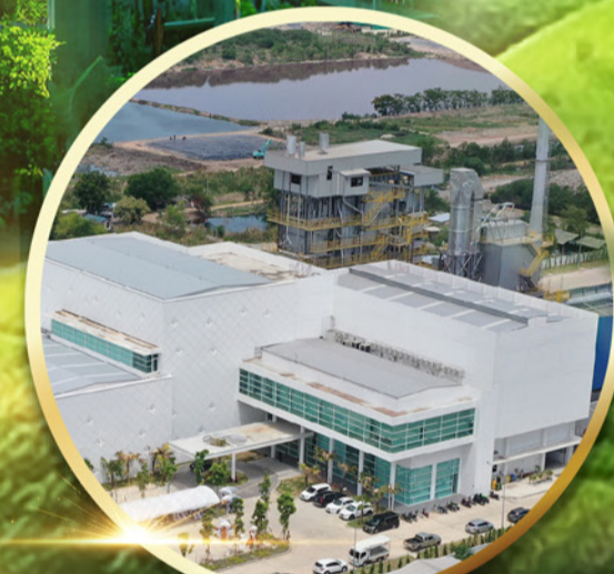
ธุรกิจโรงไฟฟ้า
